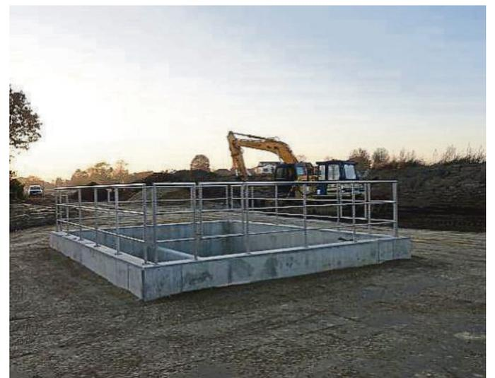
Die Arbeiten an den Klärweiher in Riedenzhofen konnten abgeschlossen werden. Jetzt befindet sich auf dem Grundstück ein Pumpwerk, dass mit Hilfe einer Druckleitung das Schmutzwasser zur Käranlage nach Dachau weiterleitet. Die Klärweiher in Riedenzhofen sind damit stillgelegt worden.
